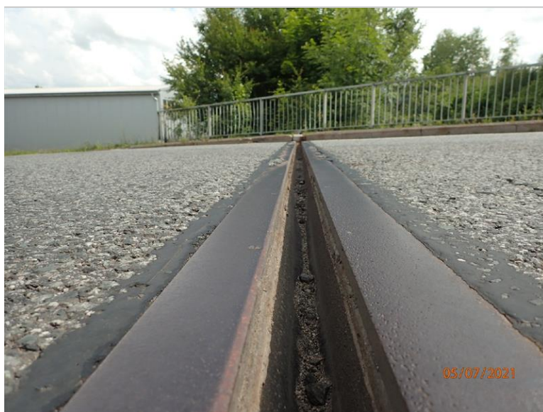
Pohled v linii vozovkového úseku mostního závěru nad O2, šířka dilatační mezery naměřena = 49 mm, vyhovuje.
