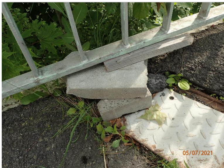
Mostní závěr nad O1, detail z výše uvedené foto, fixace polohy krycího plechu P chodníku podložkami pod zábradlím
