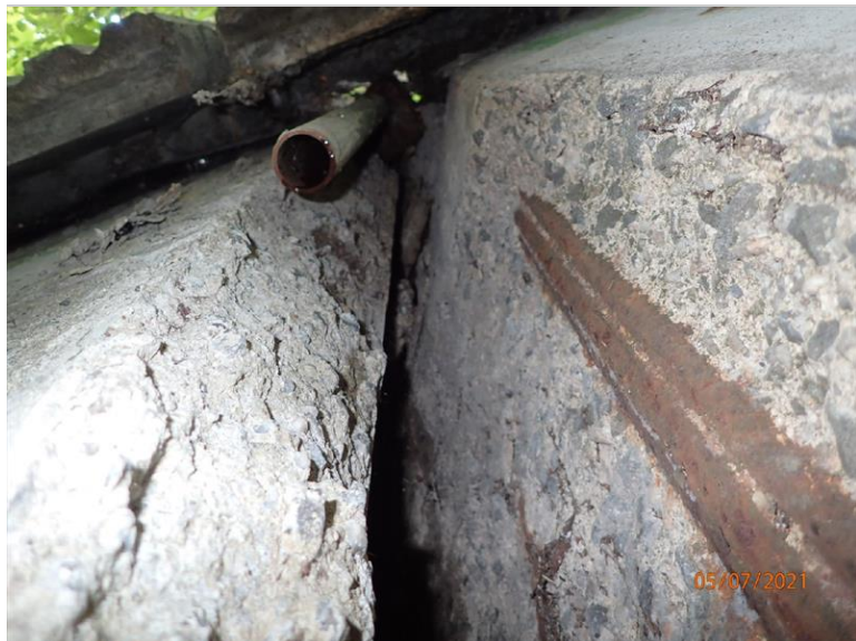
P bok opěry O1, pohled do dilatační mezery vzhůru k římsě.
