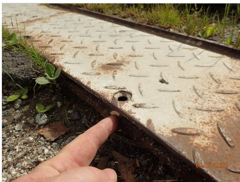
Mostní závěr nad O1, detail utržených šroubů v okraji krycího plechu P chodníku.
