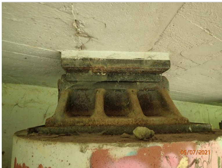
Krajní 1L ložisko na O2, běžný stav koroze na objektu.
