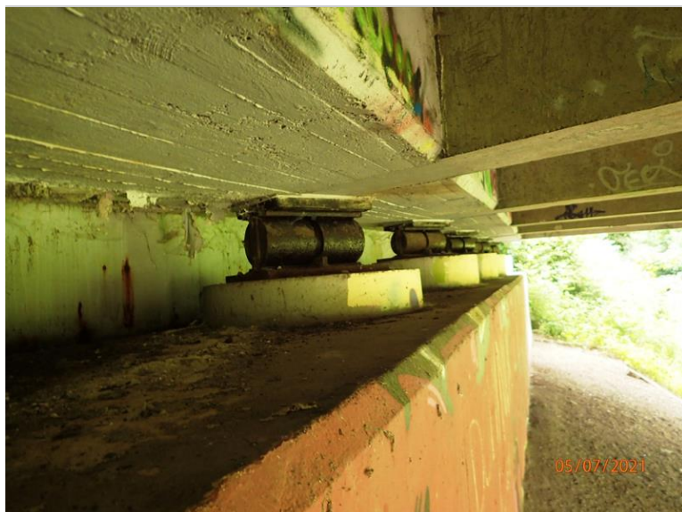
Úložný práh O1, ložiska, koncový příčník NK.
